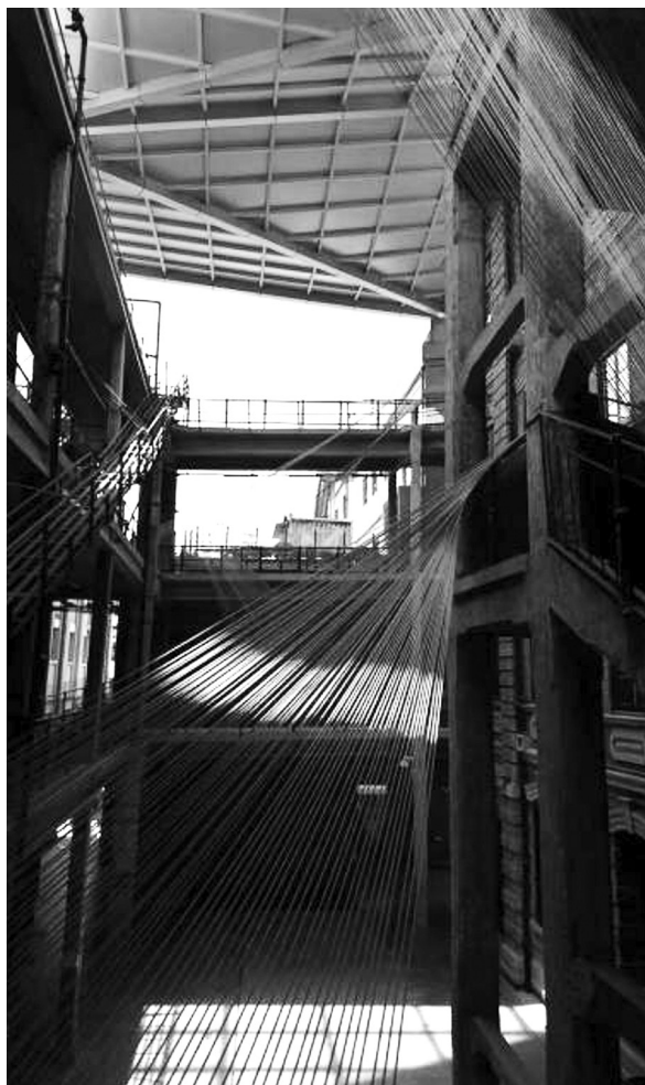
平和打包厂文创空间廊桥
