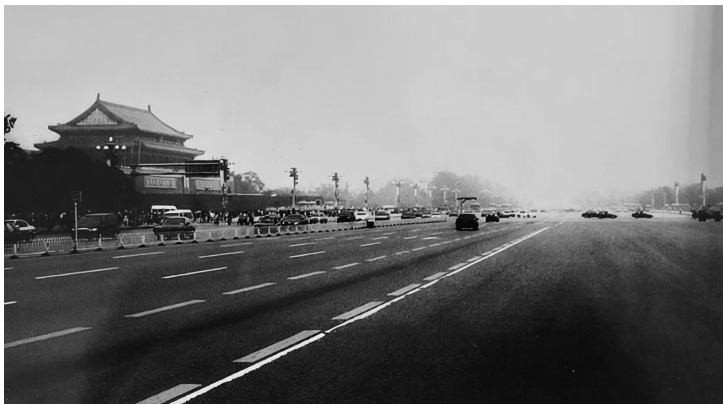
1997年喜迎香港回归，“中华第一街”东西长安街改造工程中采用国创改性沥青
