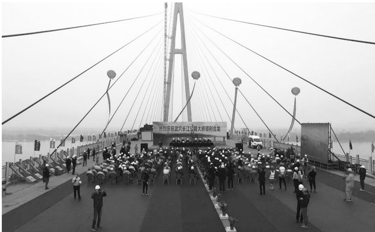
武穴长江公路大桥主桥面合龙仪式
