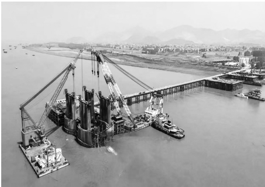
建设施工中的武穴长江公路大桥
