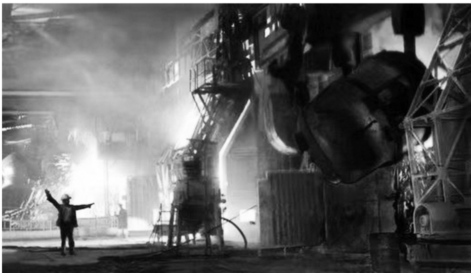
二炼钢厂兑铁水
