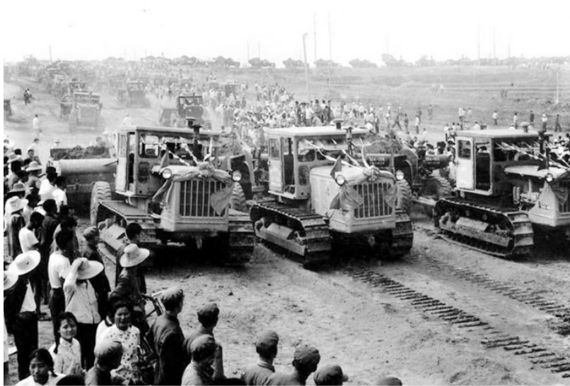
“一米七”工程开工平整场地
