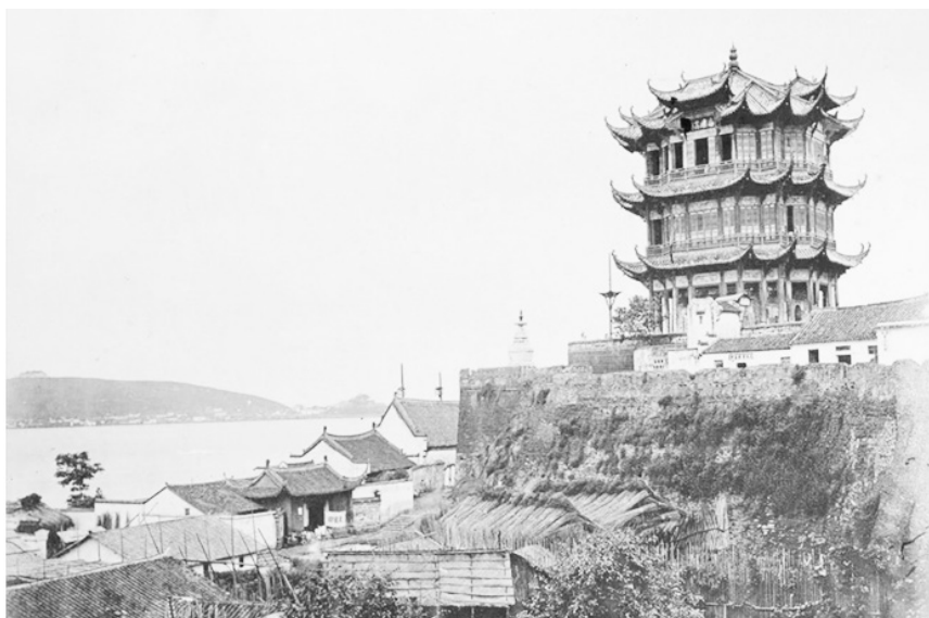
清同治黄鹤楼下城墙外，许多易燃物埋下隐患
