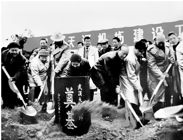
1990年12月16日，天河机场建设工程奠基
