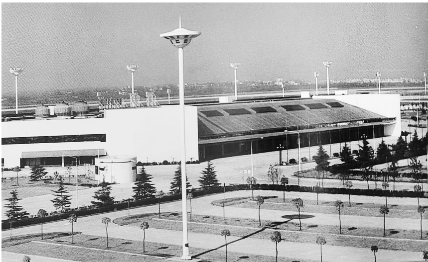
天河机场（一期工程）航站楼候机厅
