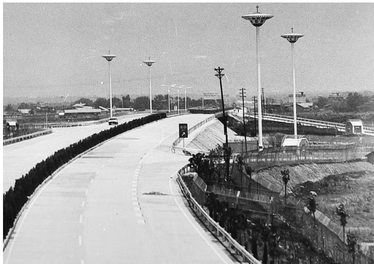
天河机场全封闭快速专用道路
