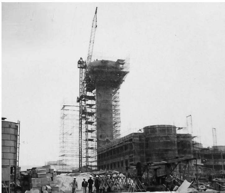
天河机场(一期工程)航站楼塔楼正在施工
