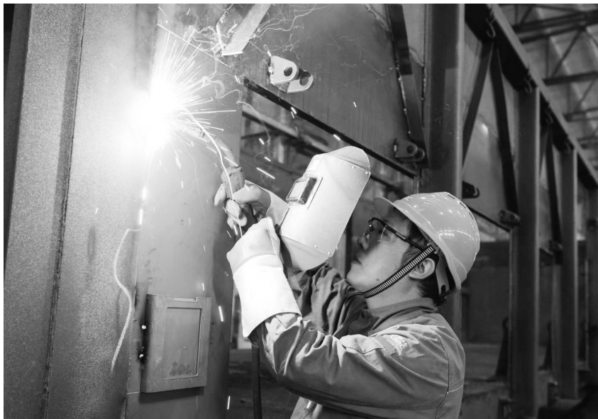
程琪进行电焊作业
