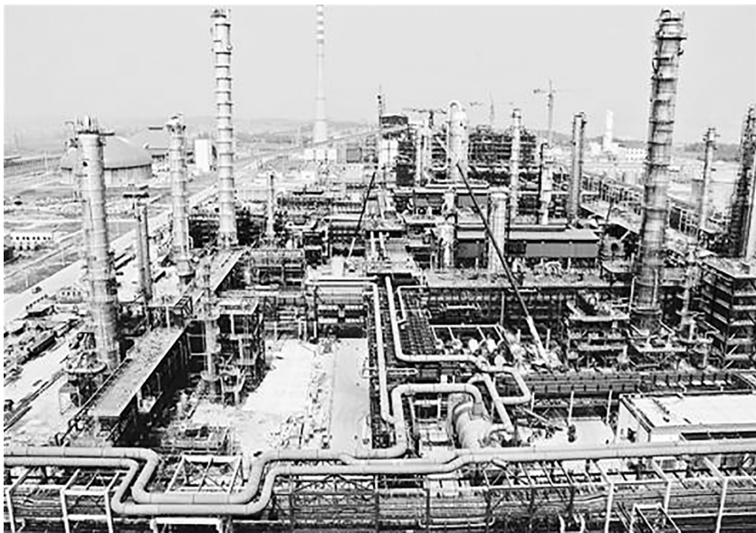
武汉 80 万吨乙烯项目现场
