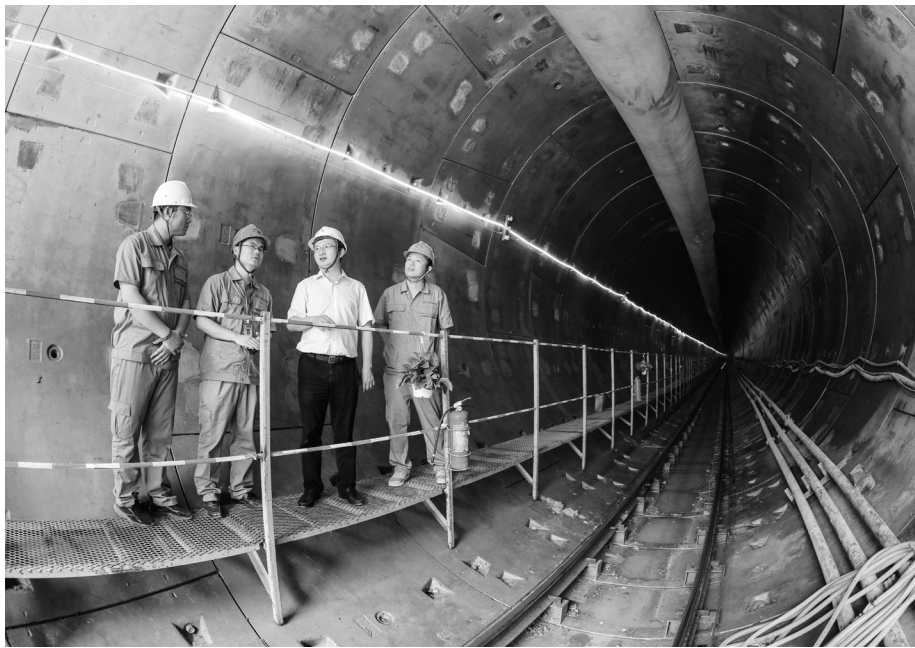
2019年9月11日，朱红西（右二）深入光谷一路排水通道工地检查工作
