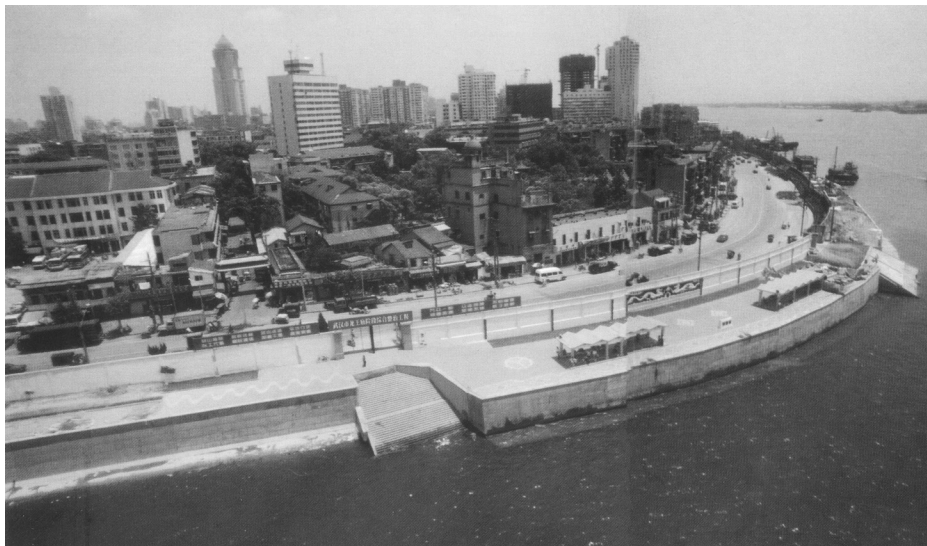
位于长江与汉水交汇处的龙王庙堤段是武汉堤防的重点险段，1998 年年底，龙王庙险段综合整治工程正式动工
