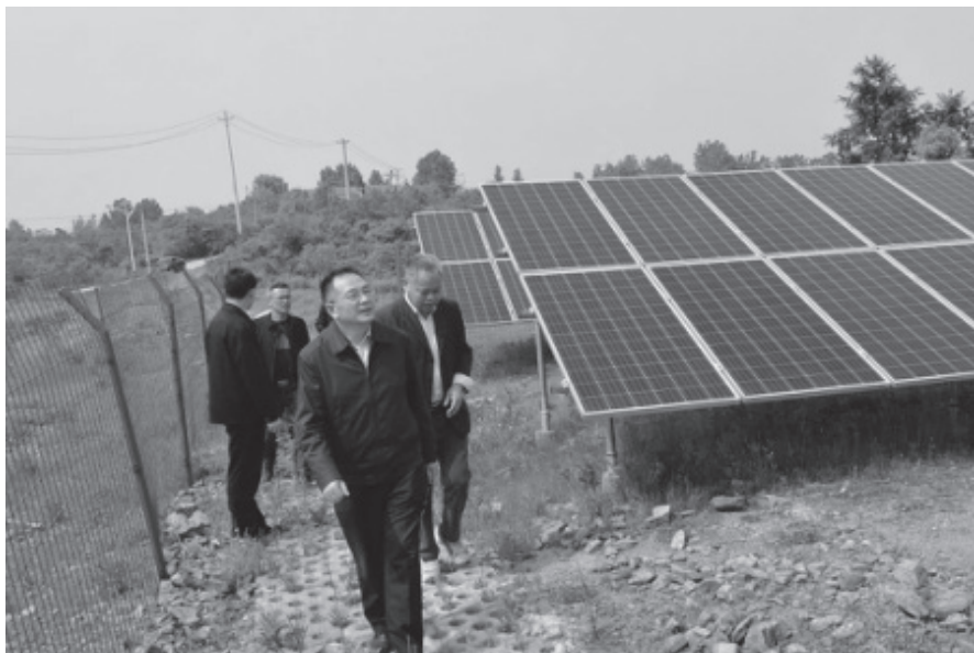
2018年4月，武汉市农委谭本忠主任（前）到新洲区李集街建新村督导精准扶贫工作，实地查看已建成的扶贫项目——90KW光伏发电现场
