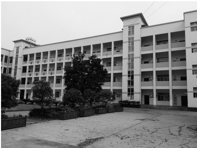
大集中心小学新建的教学楼
