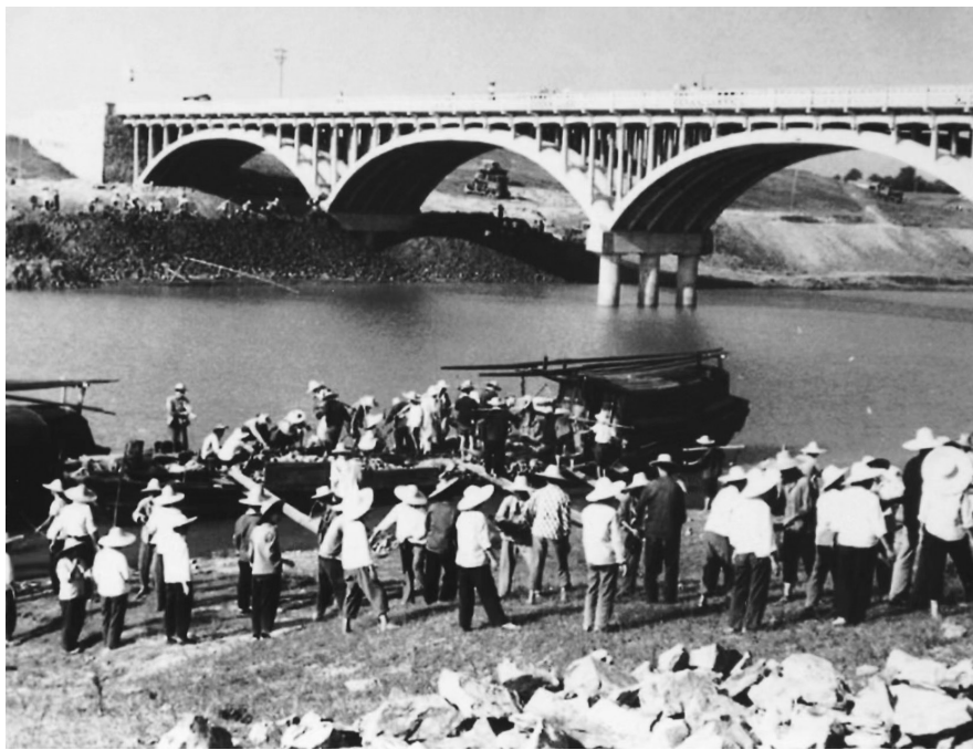
1959年修建河口大桥
