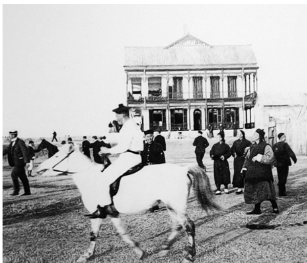
4. 现江汉关博物馆陈列的照片，说明为“1905 年以前汉口城堡内的老西商跑马场，位于今珞珈山街至一元路间”，主体建筑已更改扩建，更具西洋风格。
